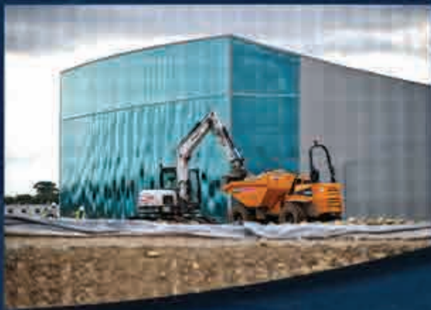
Montaż zbiorników kulistych, Zakłady Synthos Dwory, Oświęcim.
