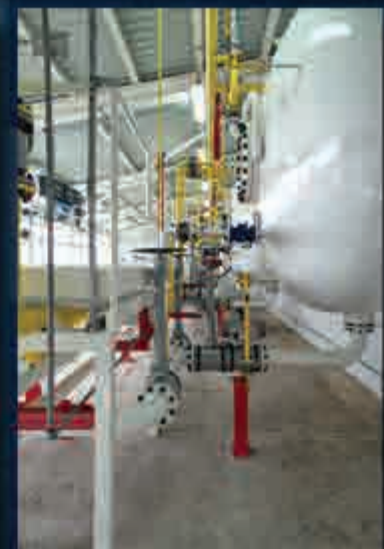
Terminal przeladunkowy gazu płynnego, Brzeźno.
