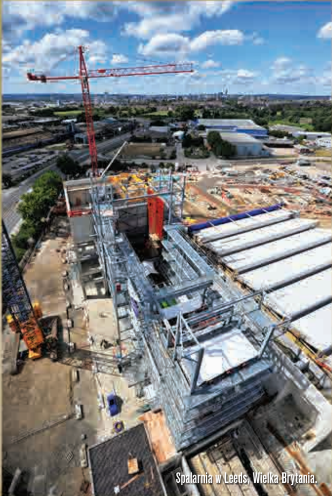
Montaż elementów kotła – spalarnia w Leeds, Wielka Brytania.
