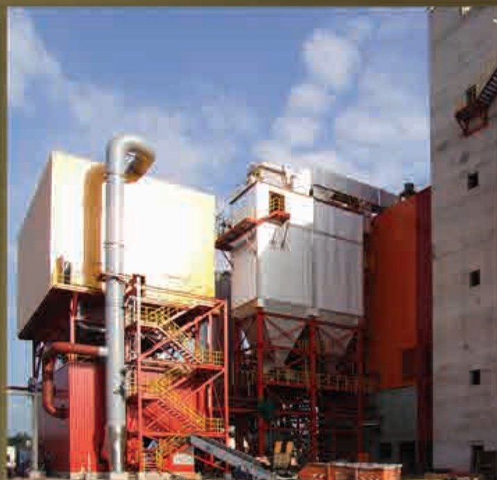
Montaż elektrofiltrów w zakładach celulozy Stendal, Niemcy.
