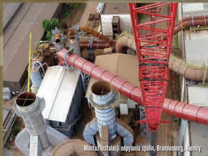
Montaż instalacji odpylenia spalin, Brandenburg, Niemcy.
