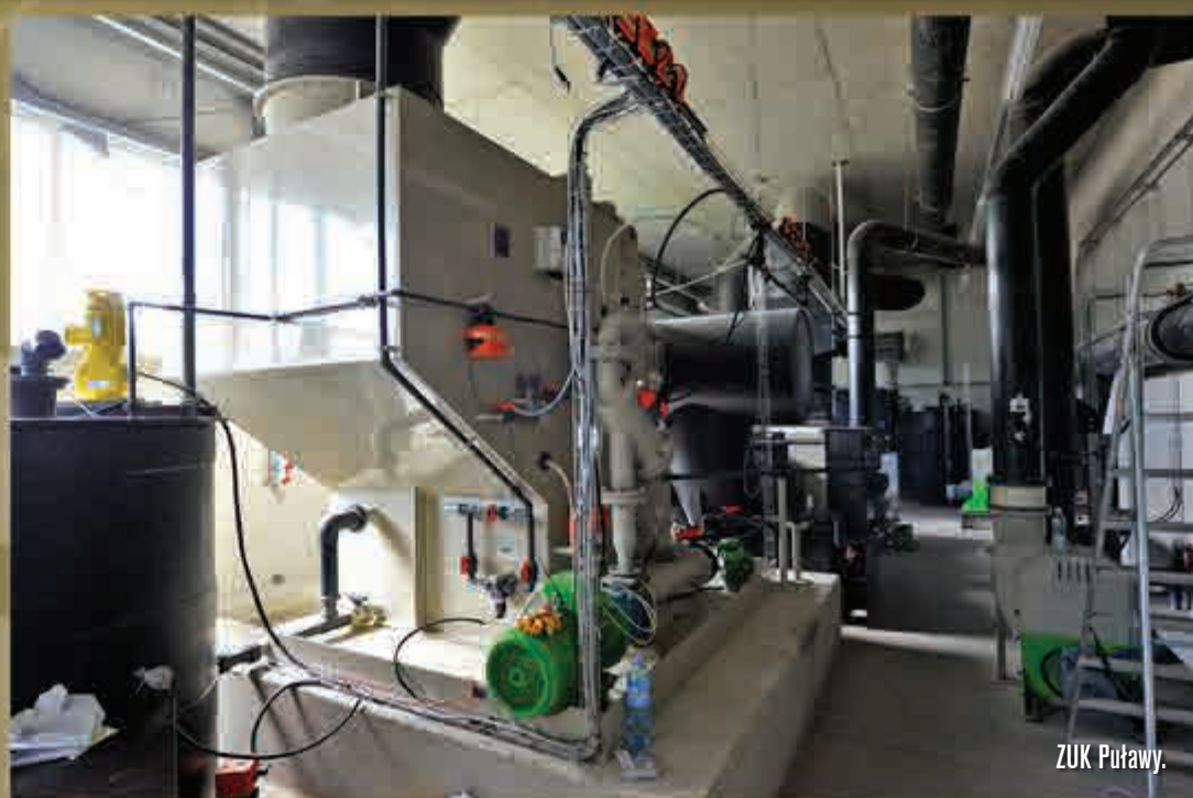
Montaż instalacji odpylenia spalin, Brandenburg, Niemcy.
