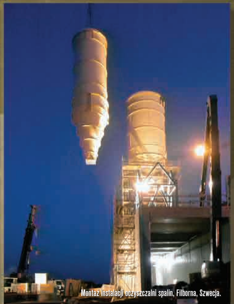
Montaż instalacji oczyszczania spalin dla nowobudowanej spalarni Västerås, Szwecja.
