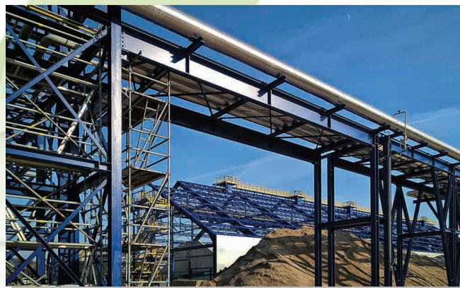
Zakłady Azotowe „Puławy” S.A., Poland
