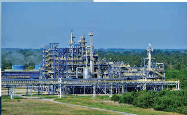
Melamina Manufacturing Plant II in Zakłady Azotowe „Puławy” S.A., Poland
