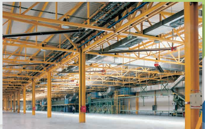
Zakłady Azotowe "Puławy" S.A., Poland
