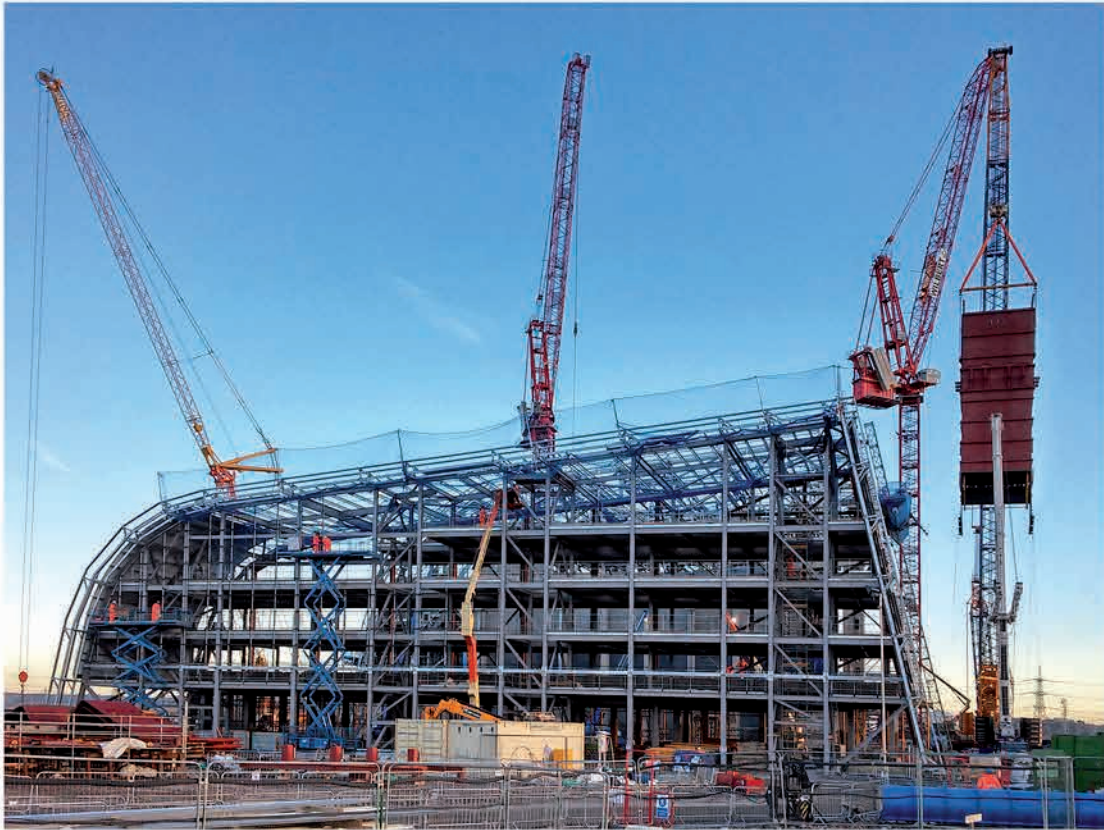
Montage von Druckbaugruppen von zwei Kesseln mit einer Leistung von 62,6 MW th in der Abfallverbrennungsanlage Severnside mit einem Jahresdurchsatz von 388 000 t/Jahr in Bristol, Großbritannien
