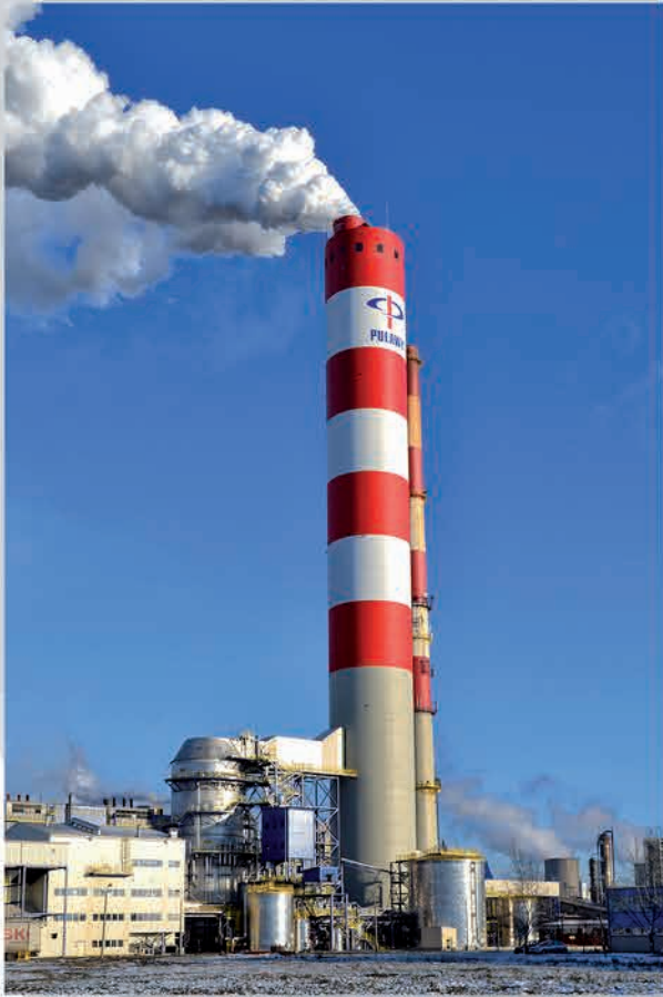
Bau der Rauchgasentschwefelungsanlage im Betrieb Zakłady Azotowe „Puławy” S.A., Polen
