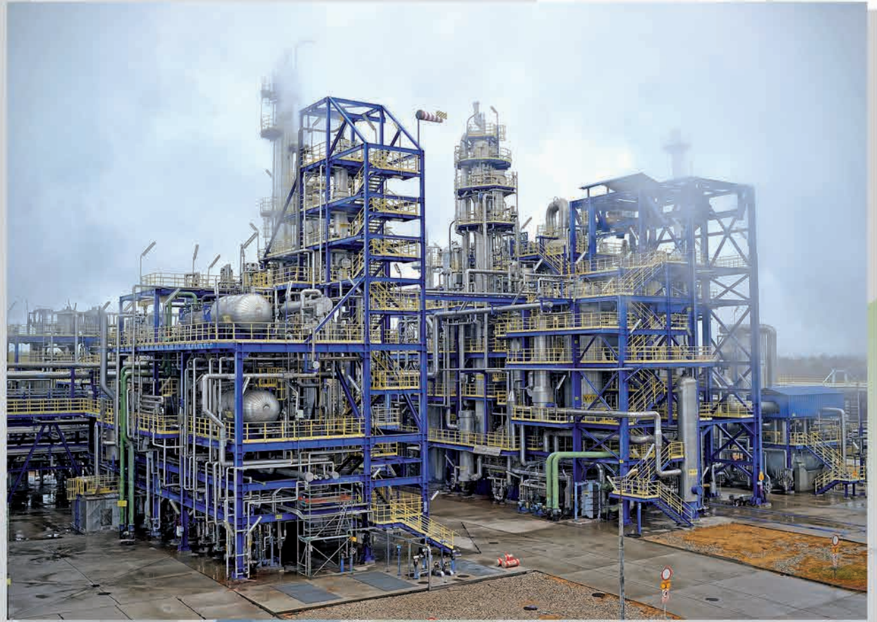
Generalausführung der Investitionsaufgabe „Bau der Melamin-Fertigungsanlage III” im Betrieb Zakłady Azotowe „Puławy” S.A. , Polen
