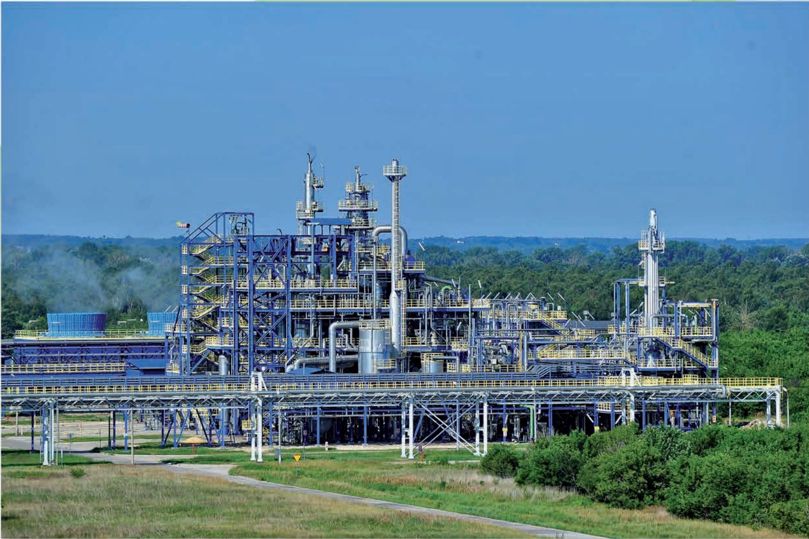
Generalausführung der Investitionsaufgabe „Bau der Melamin-Fertigungsanlage II“ im Betrieb Zakłady Azotowe „Puławy“ S.A., Polen
