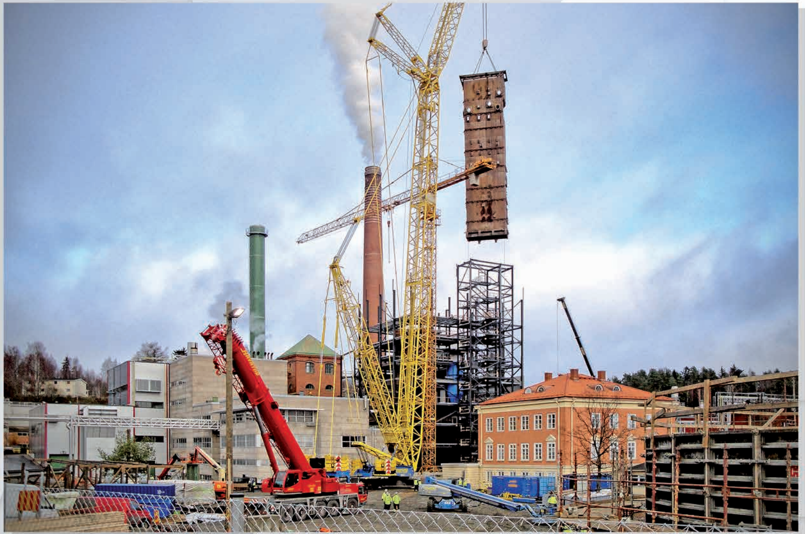
Montage des BFB-Biomassekessels zusammen mit seiner Ausrüstung und Niederdruckrohrleitungen im Heizkraftwerk HaVo in Kyröskoski, Finnland
